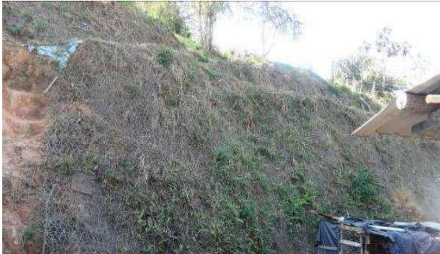
Figura 6. Utilização de telas como cobertura em taludes
