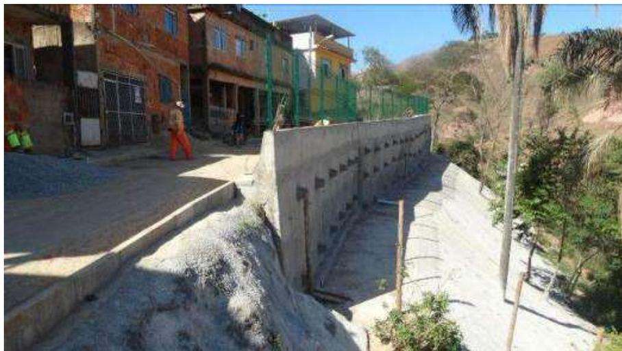
Figura 7. Construção de muro de arrimo
