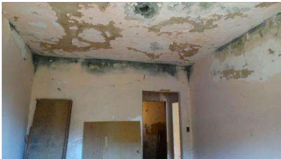
Figura 8. Exemplo de edificação de baixo padrão, com acúmulo de mofo em laje
