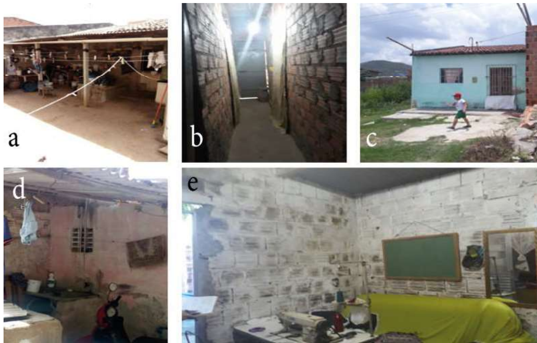
Figura 39. Iluminação e ventilação.
