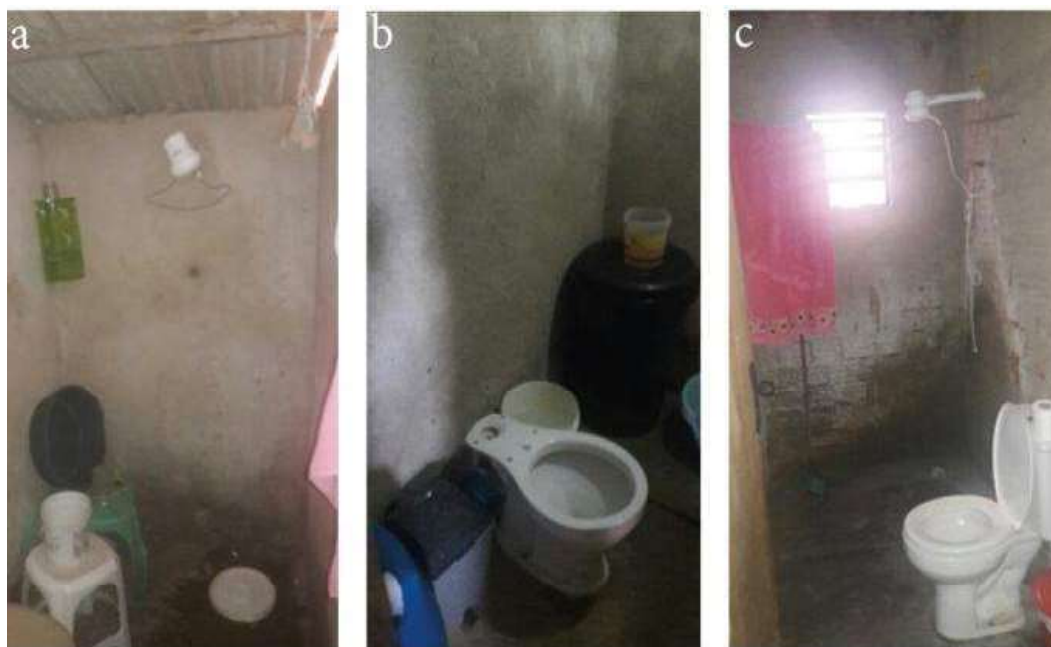
Figura 35. Banheiros residências vistoriadas.
