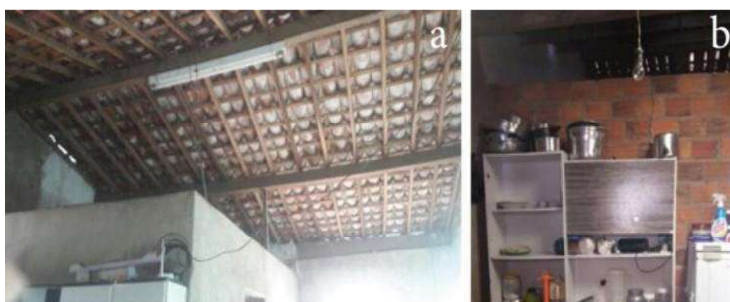
Figura 37. Instalações elétricas moradias vistoriadas.
