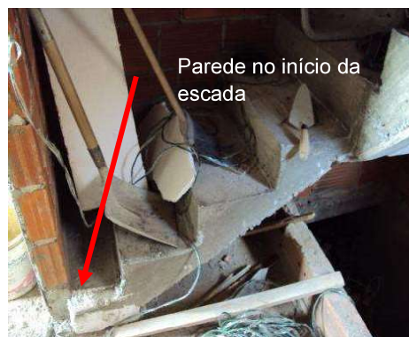
Figura 3. Escada terminando na parede
