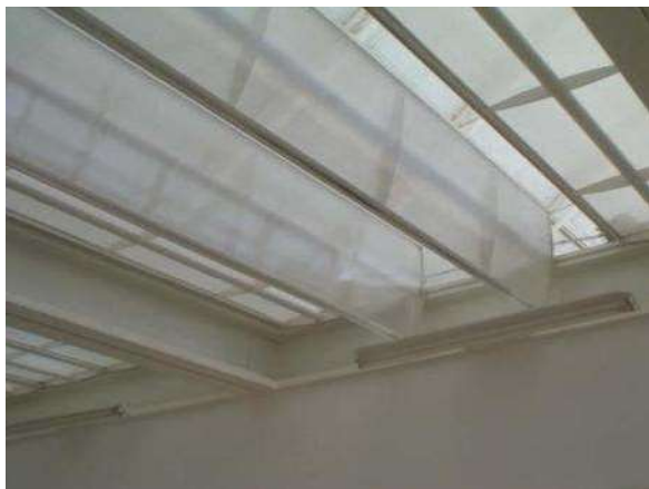
Figura 3. Sistema de painéis basculantes internos, acervo CTRS (2008).
