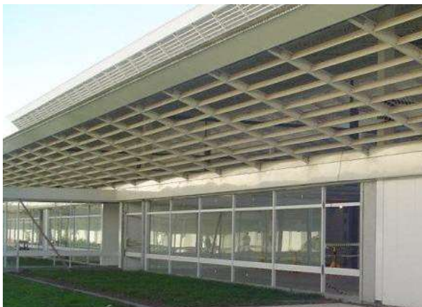
Figura 4. Vista dos basculantes dos sheds, acervo CTRS (2008).
