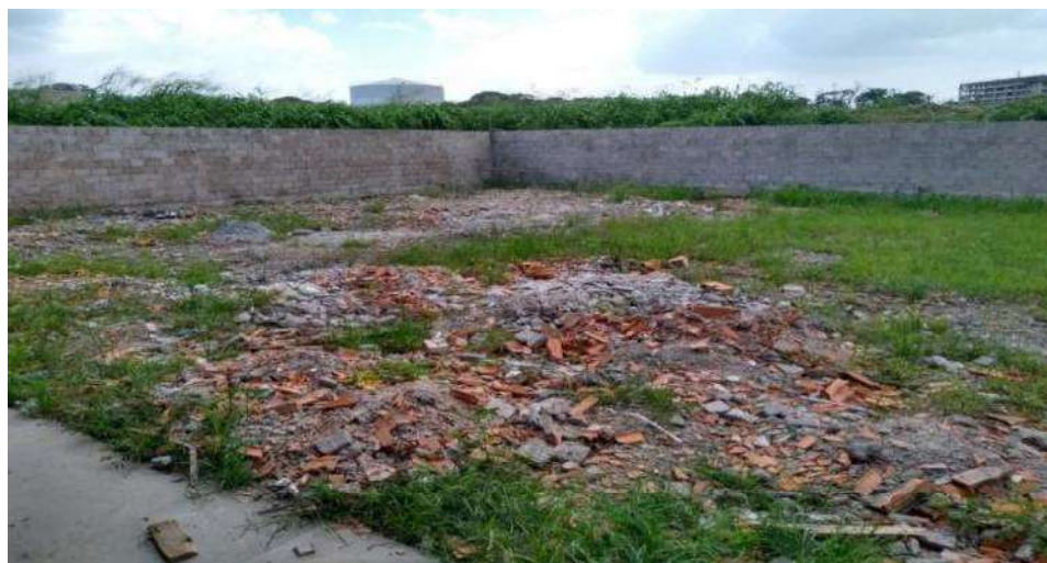
Figura 6. Aterramento com utilização de material de demolição.
