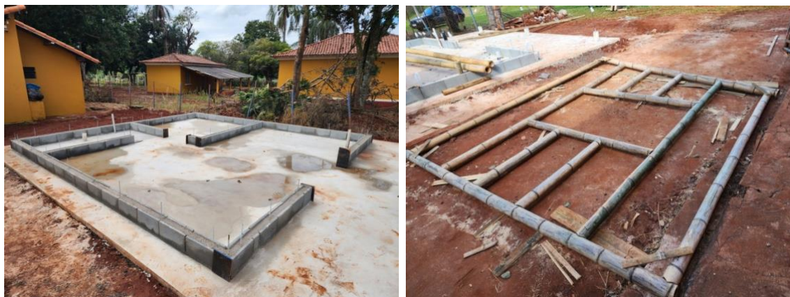
Figura 5. Fundação e painel somente com ossatura.
