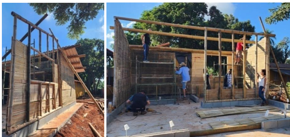
Figura 6. Exemplo de painéis sendo instalados, parte com esterilla e parte sem.
