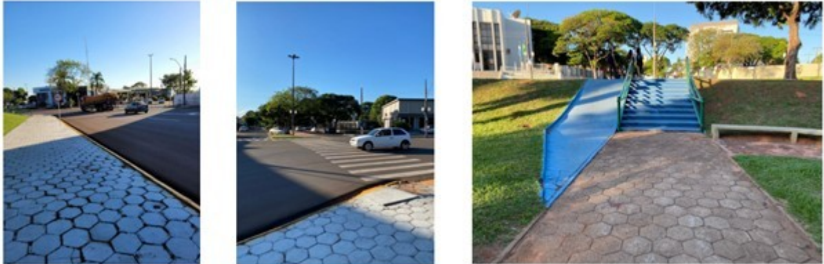
Figura 5. Rampas e calçadas na Praça Central Euclides Antônio Fabris, na cidade de Naviraí – Mato Grosso do Sul, Brasil.
