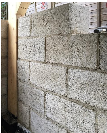
Figura 4 e 5. Utilização do hempcrete nas construções.
