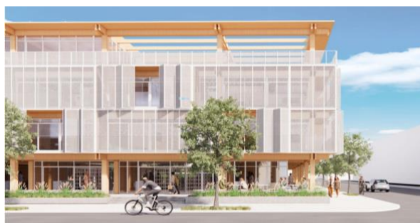
Figura 6. Vista da fachada Leste com envoltória em painéis de proteção solar (acad. Natalia Pasqualotto, Rodrigo Alves, Lucas Oliveira).
