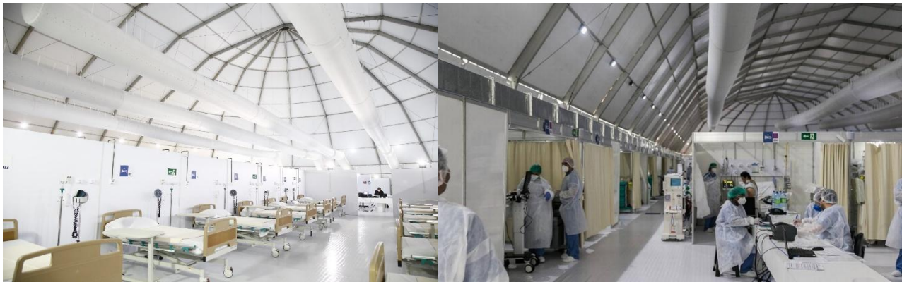
Figura 2: Estrutura interna do Hospital de Campanha Lagoa Barra. Fonte: Instituto Brasileiro de Petróleo, Gás e Biocombustíveis (2020).
