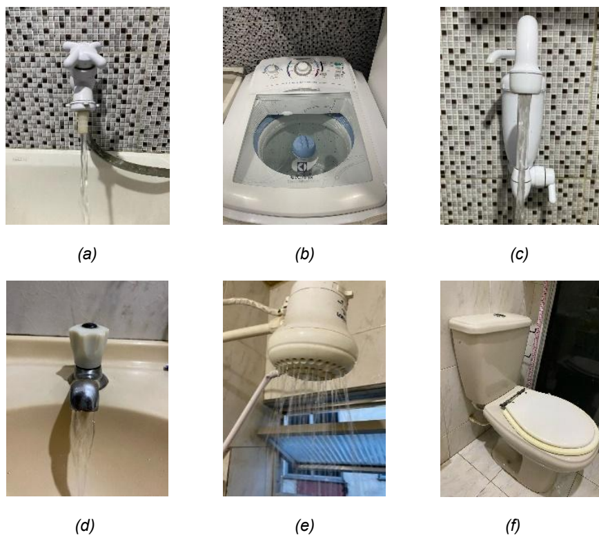
Figura 2: Aparelhos sanitários existentes em um dos apartamentos analisados: (a) Tanque com torneira monocomando; (b) Máquina de lavar roupa; (c) Pia com torneira monocomando; (d) Lavatório com torneira monocomando; (e) Chuveiro elétrico; e (f) Bacia sanitária com caixa acoplada e descarga simples.
