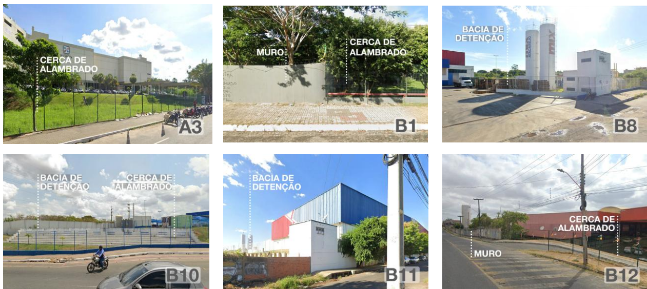
Figura 5: Fechamentos no entorno das bacias de retenção ou detenção presentes nos empreendimentos analisados. Fonte: Os Autores (2025).
