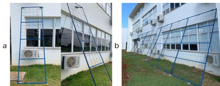
Figura 3: Protótipo inicial e estrutura instalada. Fonte: Autores (2024).
