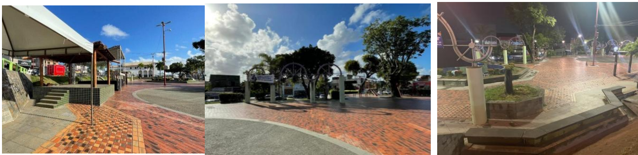
Figura 4: Diferentes vistas da praça em diferentes momentos do dia: coreto, área do parque infantil, acesso 1.
