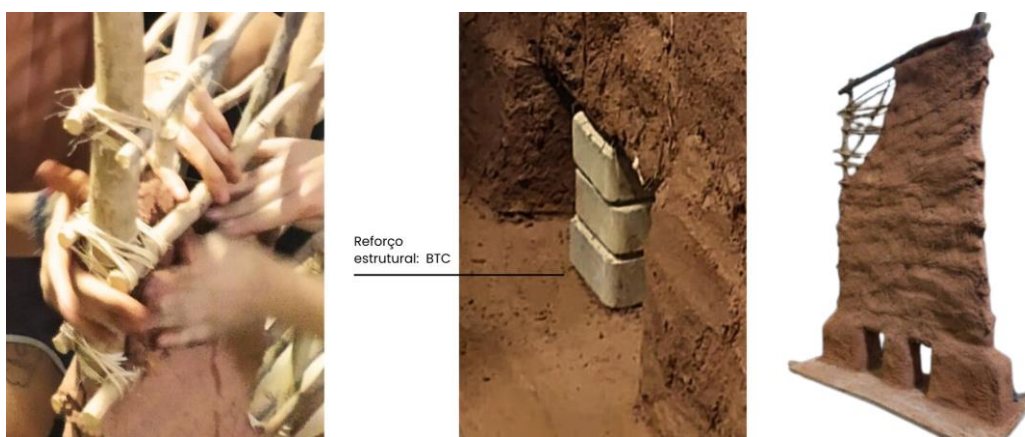
Figura 6: Processo final de construção do painel Fonte: os autores (2023).
