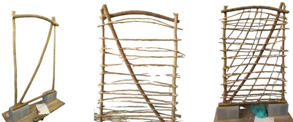
Figura 4: Evolução da confecção do entramado de madeira. Fonte: os autores (2023).
