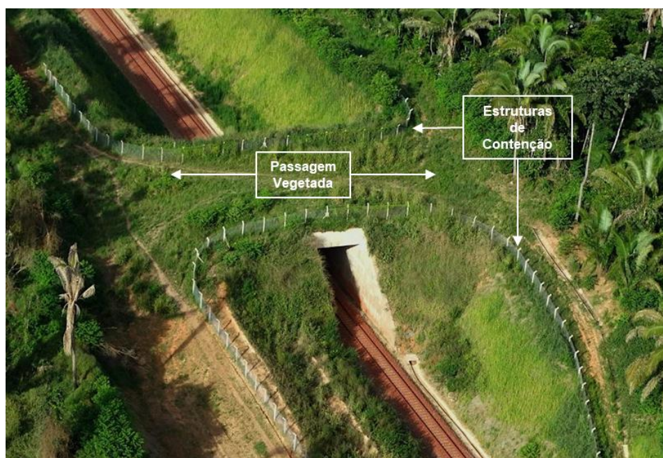
Figura 2: Primeiro viaduto com travessia para fauna no Brasil.
