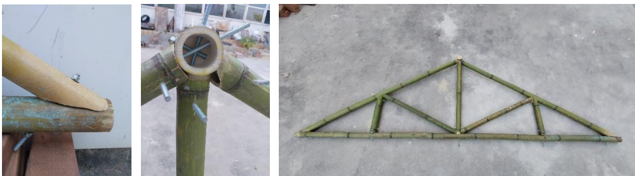
Figura 5: Encaixes realizados e tesoura finalizada. Fonte: Os autores.
