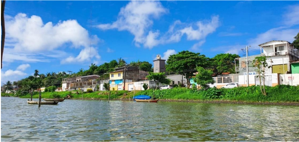
Figura 3: Ocupações irregulares nas margens do Rio Bacanga (2024) Fonte: os autores (2025).
