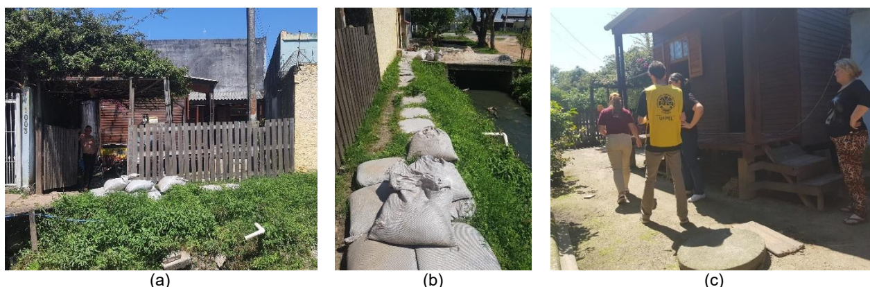
Figura 2 – Levantamento técnico. (a) Frente do lote; (b) Entorno imediato; (c) Realização de medições técnicas Fonte: Acervo do EMAU JoãoBem
