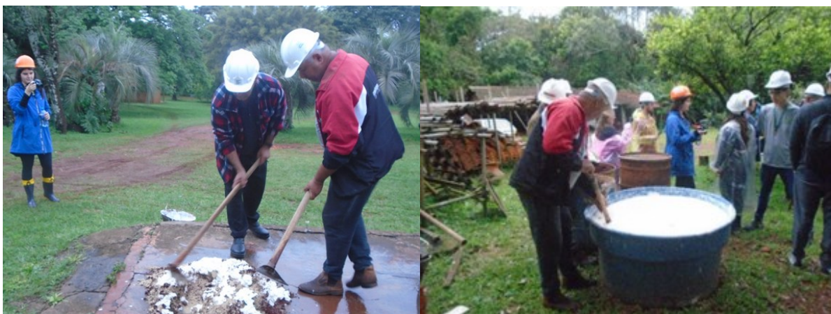
Figura 6 - Preparo da argamassa utilizada na consolidação. Fonte: Os autores (2024).
