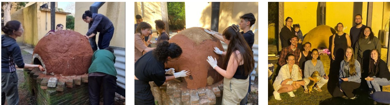
Figura 3: As duas primeiras fotos são registros das oficinas (reboco grosso e fino); e a última foto uma confraternização do grupo após a requalificação do forno. Fonte: Arquivo EMAU JoãoBem (2024).
