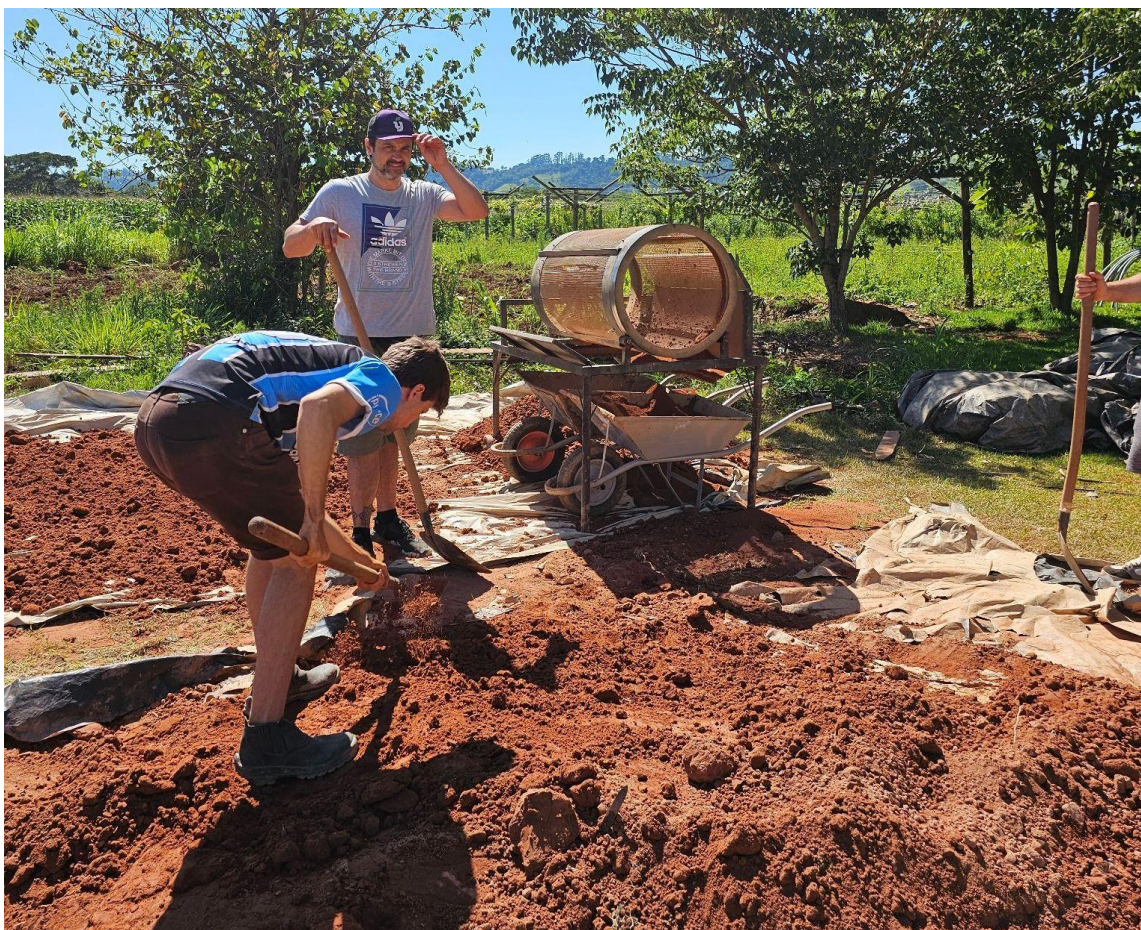
Figura 2: Processo de peneiramento do solo, antes do dia de execução da parede. Fonte: autores. Fonte: Os autores (2025).
