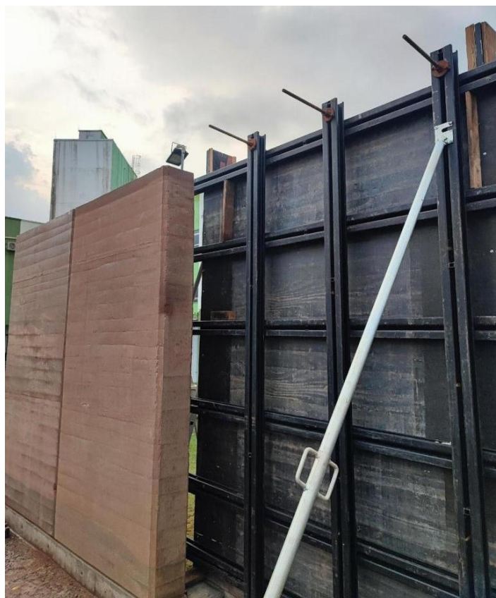
Figura 1: Sistema de formas adotadas para execução das paredes em Taipa de Pilão. Fonte: Os autores (2025).
