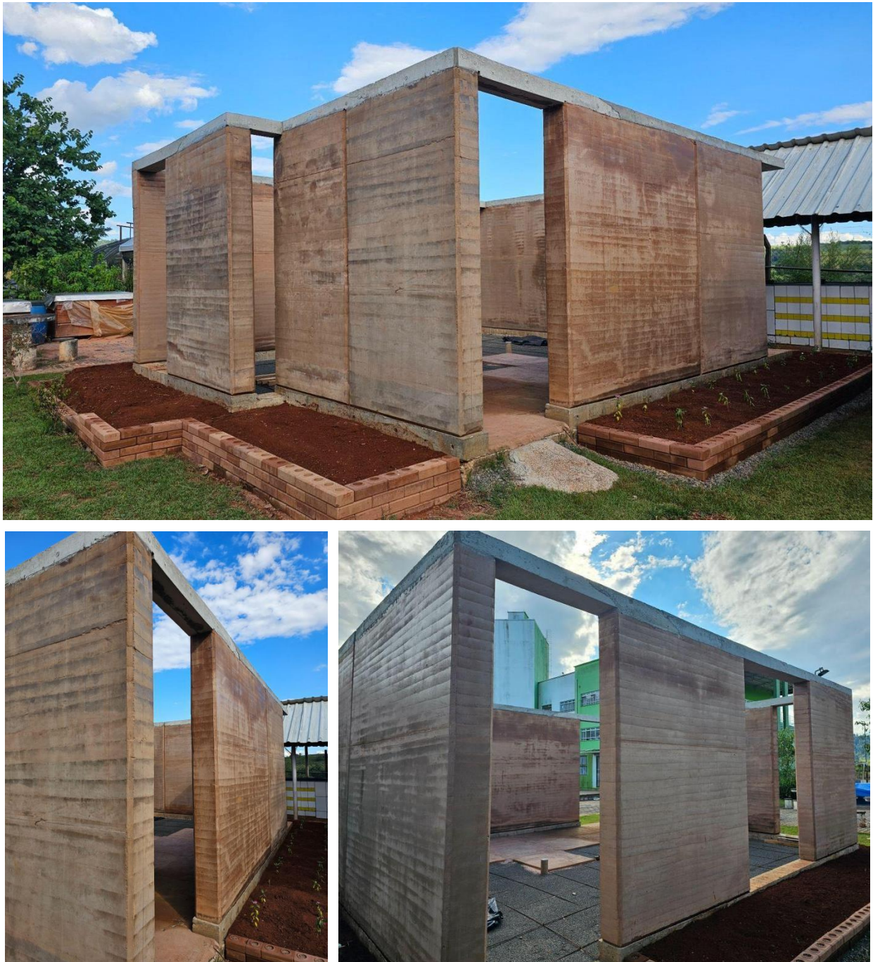
Figura 3: Detalhes das paredes vistas da entrada principal da Casa-Laboratório.
