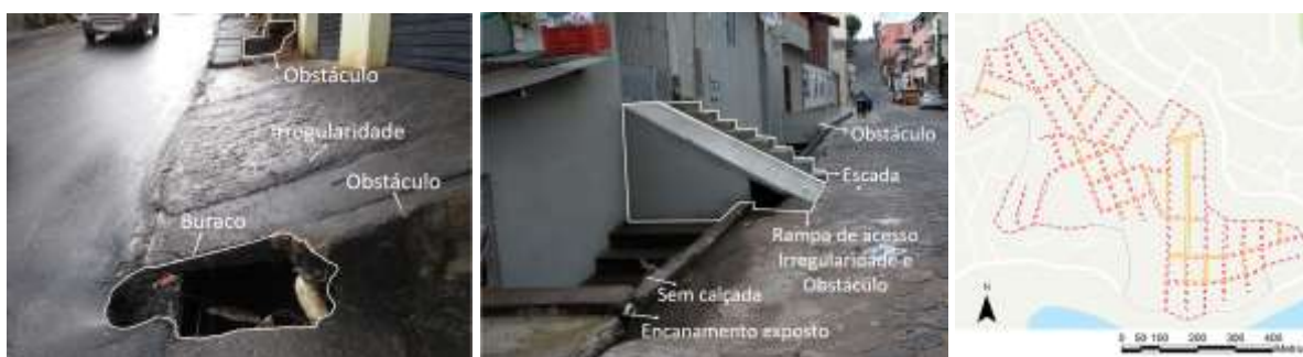
Figura 1 – Obstáculos, irregularidades e buracos na calçada
