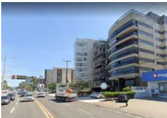
Figura 9 – Perspectiva comercial do edifício Ana Lidya
