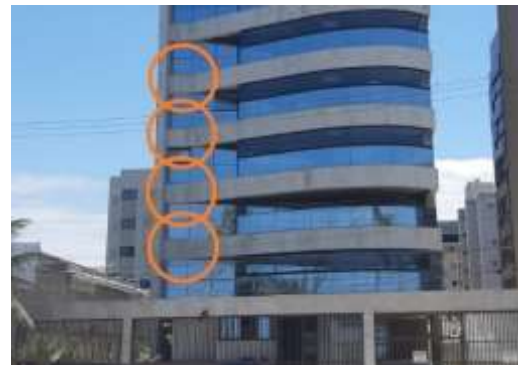
Figura 7 – Detalhe da composição executada do volume da viga
