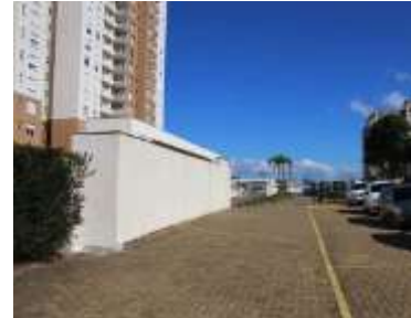
Figura 3 – Térreo residencial sem permeabilidade visual – Caxias do Sul
