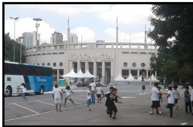
Figura 1 – Vista da Fachada Norte do Estádio Paulo Machado de Carvalho - Pacaembu.
