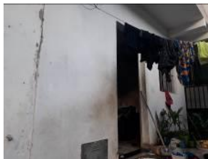
Figura 6 – Tipologia arquitetônica da área externa da residência
