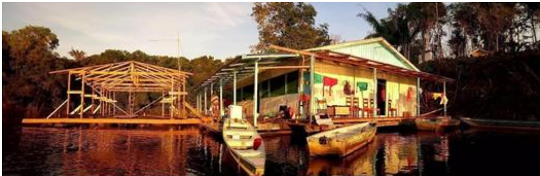
Figura 2 – À esquerda, a estrutura de madeira de uma casa flutuante ainda em construção. À direita, casa flutuante já finalizada -
