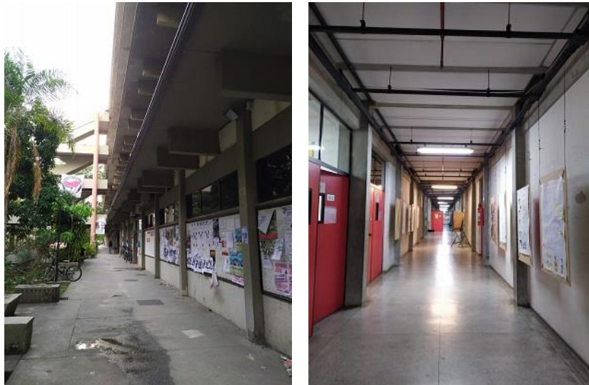
Figuras 5 e 6 – Bloco D: Fachada e Corredor do 5º andar -
