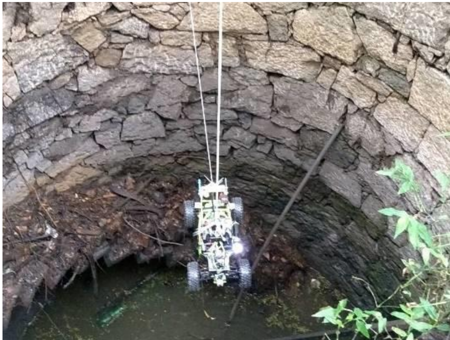
Figura 7 – Vistoria teste em poço de interesse histórico no NAHM -
