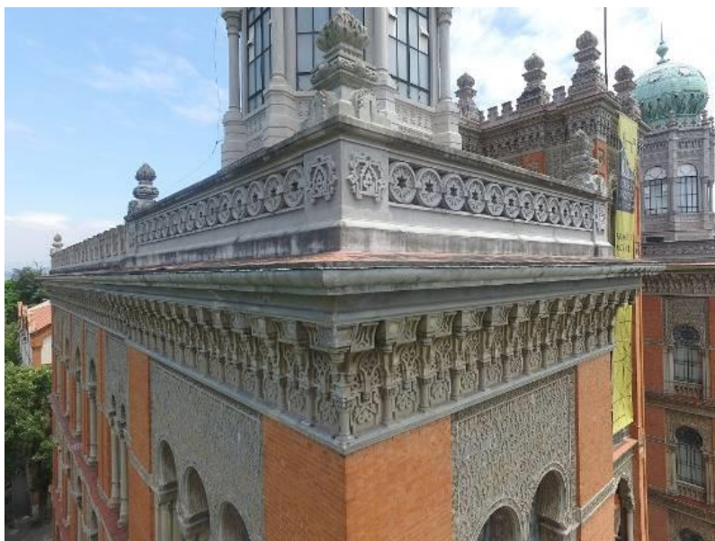
Figura 3 – Inspeção nos elementos de cobertura realizada com o uso de drone no Pavilhão Mourisco - Fonte: DPH (2018)
