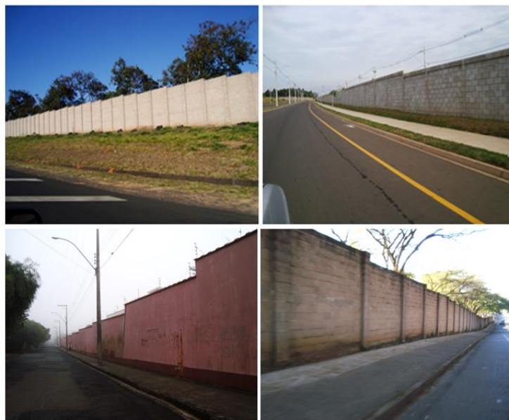
Figura 1 - Falta de Permeabilidade – muros cegos dos CHF's
