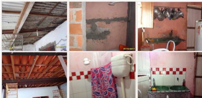
Figura 3 – Melhorias realizadas na casa B -
