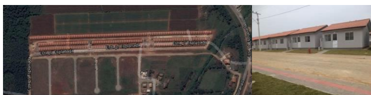
Figura 7 – Vista área do Empreendimento A e fachada da UH Padrão -
