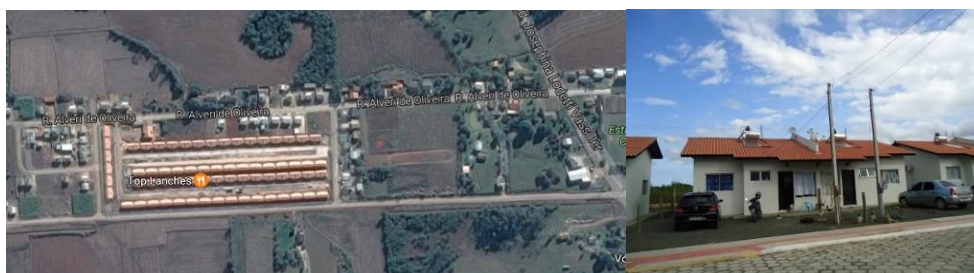
Figura 10 – Vista área do Empreendimento D e fachada da UH Padrão -
