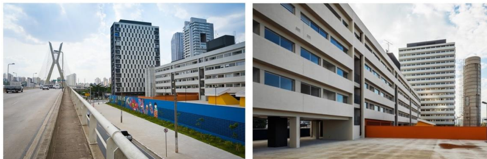
Figura 6 – Terraço sobre o embasamento -
