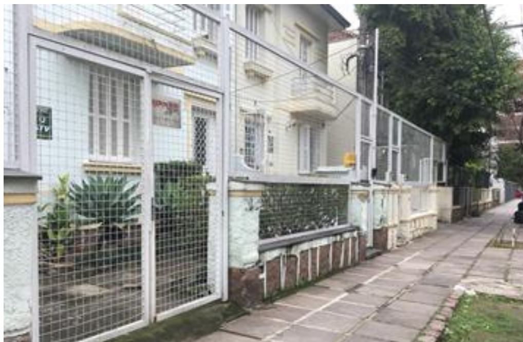
Figura 7 – Percurso 6: Rua Sofia Veloso - Edificações alinhadas e recuadas em relação ao passeio
