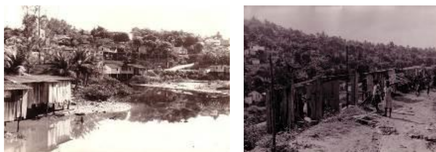
Figura 3 – Construção de barracos em Porto de Santana, Cariacica, 1982
