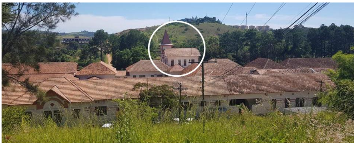
Fig.1: Torre de controle da Assistência de Alienados de Barbacena (atual FHEMIG).
