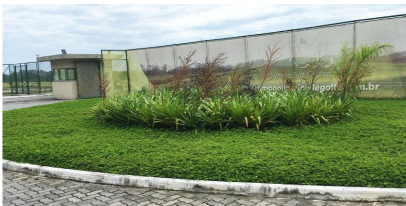
Figura 2 – Portaria e cercamento do Campo Olímpico de Golfe do Rio de Janeiro
