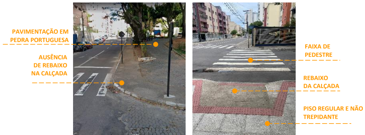
Figura 3 – Travessia antes da reforma (à esquerda) e travessia pós reforma (à direita).
