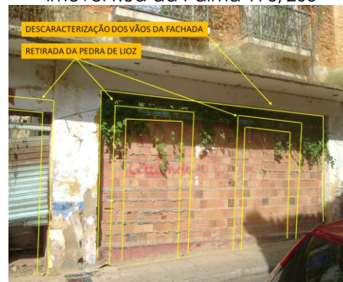
Figura 2 – Fachada principal (vista B) imóvel Rua da Palma 195/205
