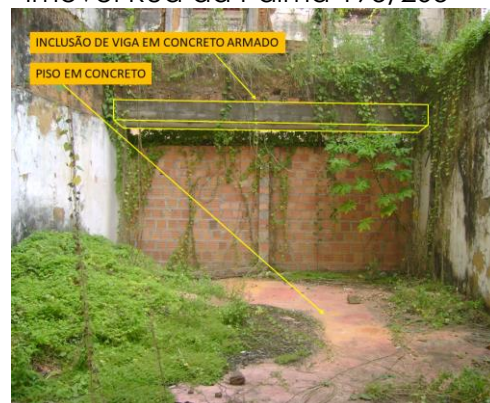
Figura 4 – Interior do pavimento térreo imóvel Rua da Palma 195/205
