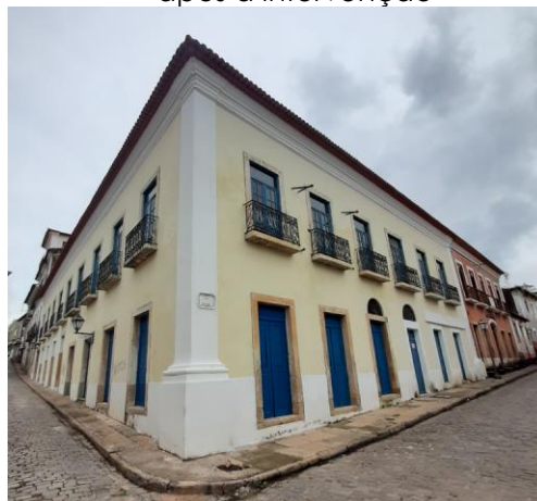
Figura 7 – Imóvel Rua da Palma 195/205 após a intervenção
