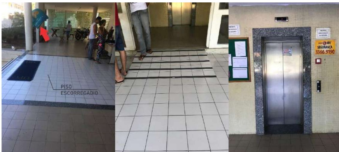
Figuras 8, 9 e 10 – Área dos pilotis, rampa para hall, elevador -
