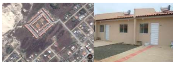
Figura 9 – Vista área do Empreendimento C e fachada da UH Padrão -
