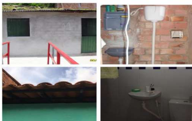
Figura 10 – Melhorias realizadas na casa I -
