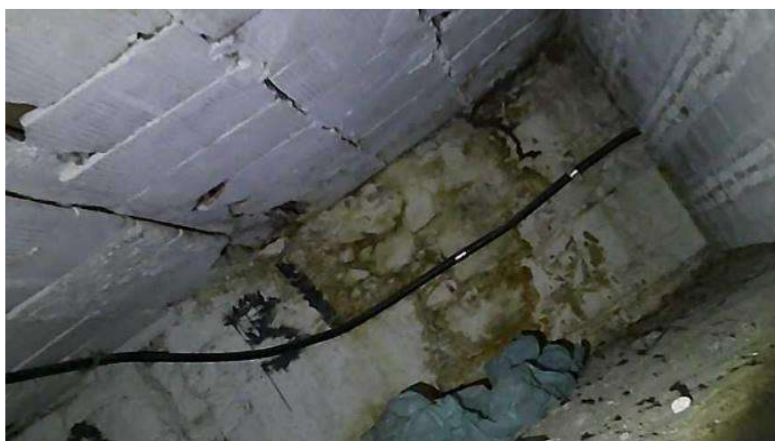
Figura 6 – Vistoria teste em entreferro do 3º pavimento do Pavilhão Mourisco - Fonte: DPH (2019)
