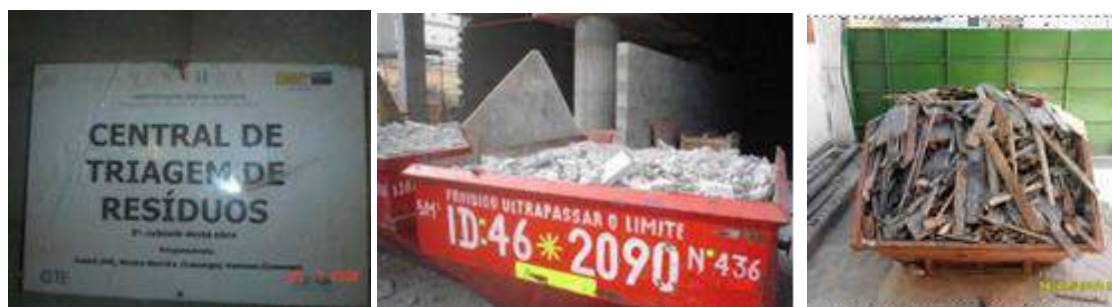
Figura 6 – Triagem de resíduos durante a obra
