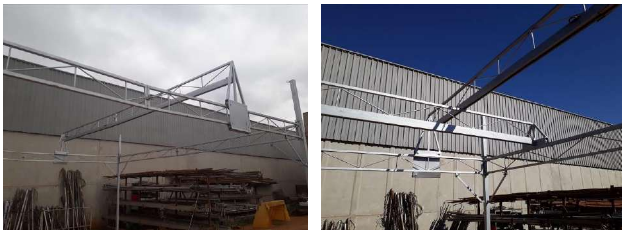
Figura 8 – Protótipo metálico inicial com estrutura treliçada.
