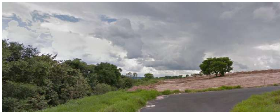
Figura 2 – Construção de loteamento próximo a mata ciliar.
