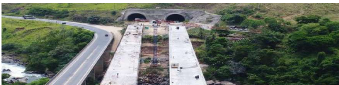
Figura 2 – Ligação entre pontes e túneis no trecho escolhido para a pesquisa (11/03/19)
