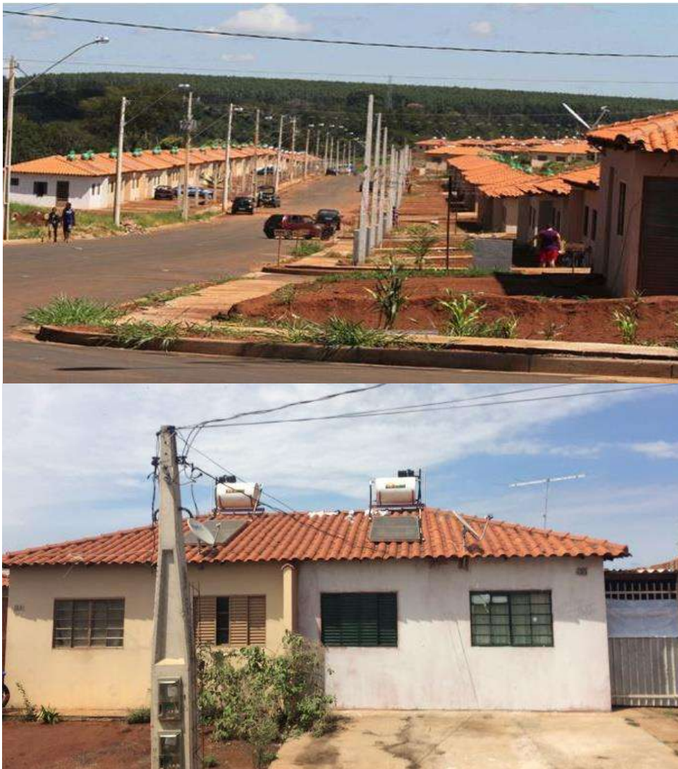
Figura 2 – Fotos rua do CHIS e casas geminadas.
