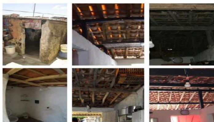
Figura 11 – Melhorias realizadas na casa J -
