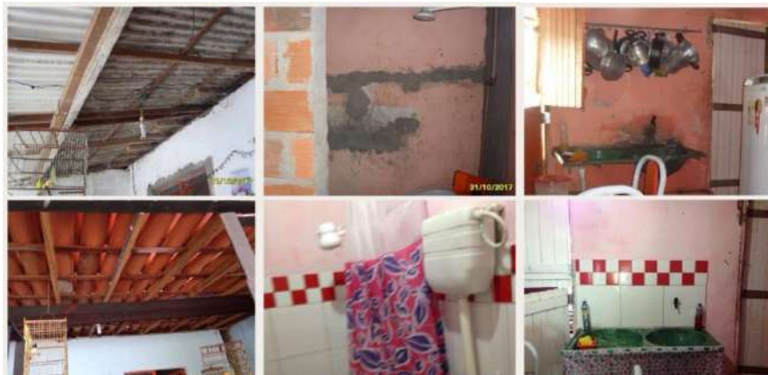
Figura 3 – Melhorias realizadas na casa B -
