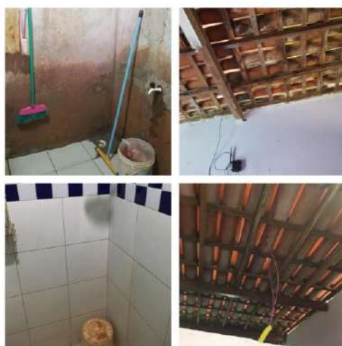
Figura 9 – Melhorias realizadas na casa H -
