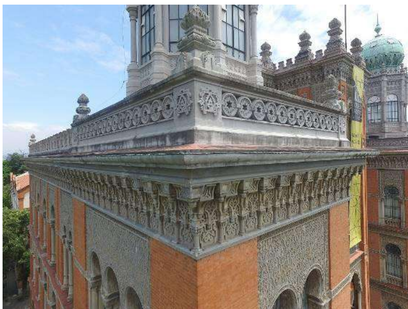
Figura 3 – Inspeção nos elementos de cobertura realizada com o uso de drone no Pavilhão Mourisco -
