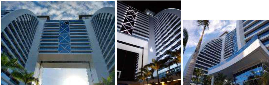
Figura 15 – Visão Diurna e noturna da edificação
