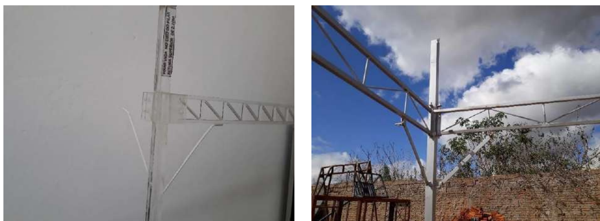
Figura 6 – Fotos do modelo na escala 1:4 e da estrutura executada
