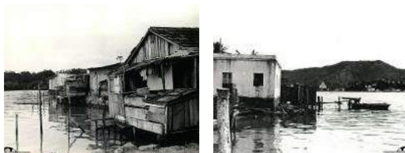
Figura 4 – Ocupações espontâneas e palafitas em Porto de Santana, 1985
