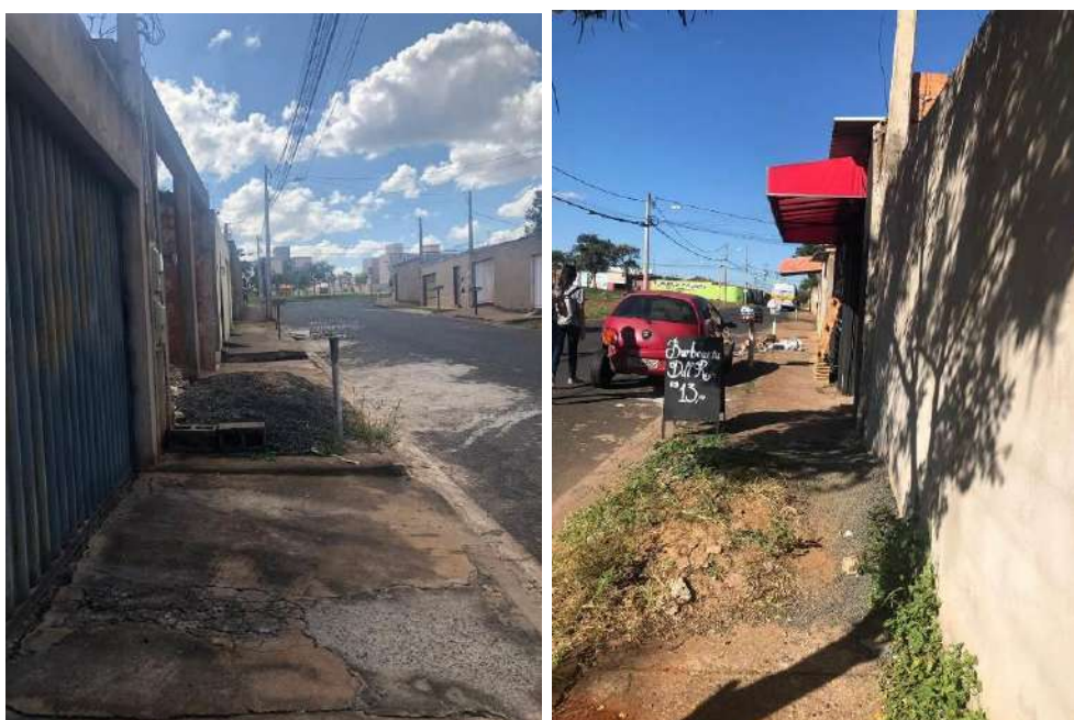
Figura 6 – Foto esquerda: Estado das calçadas na rua João Rodrigues Filho. Foto direita: Estado da calçada na rua SP-132 -
