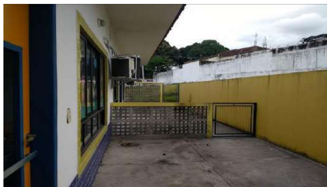
Figura 4 – A ausência de elementos de proteção na janela e as dimensões do beiral não são suficientes para evitar a insolação direta no período da tarde -
