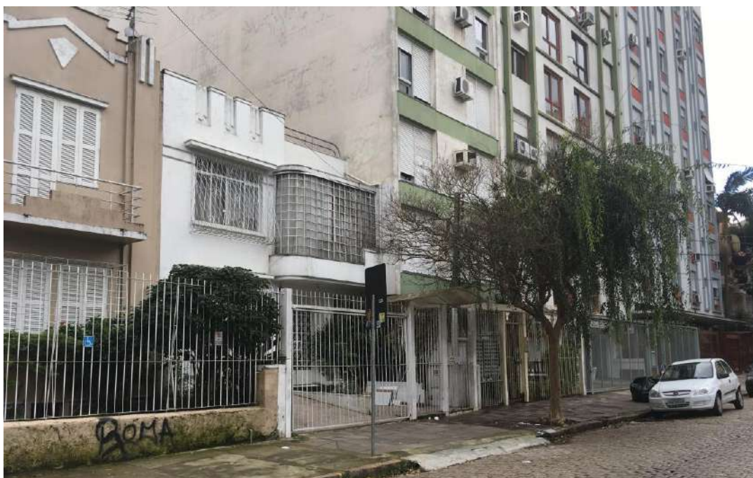
Figura 4 – Percurso 3: Rua Sofia Veloso – Edificações alinhadas e recuadas em relação ao passeio
