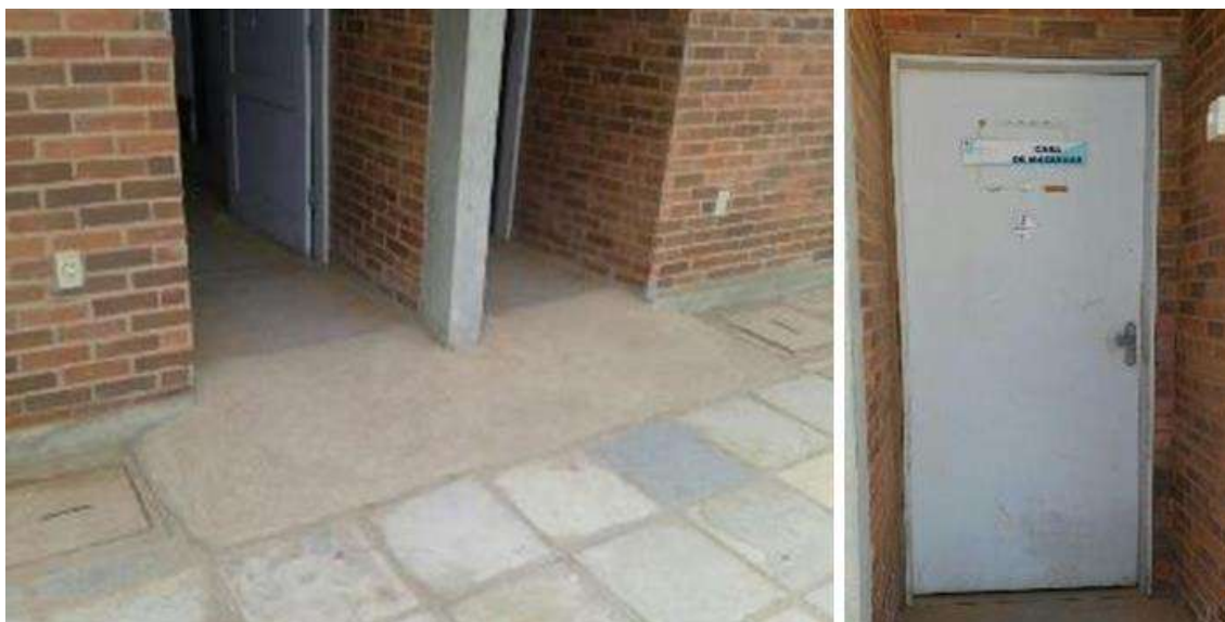
Figura 5 – Acesso aos vestiários e porta dos vestiários, respectivamente -
