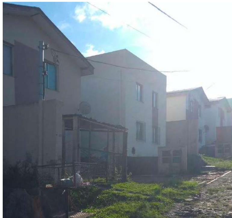
Figura 2 – Sobrado com telhado modificado Fonte: FERREIRA (2017a)
