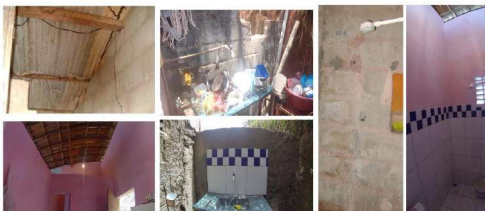
Figura 2 – Melhorias realizadas na casa A -
