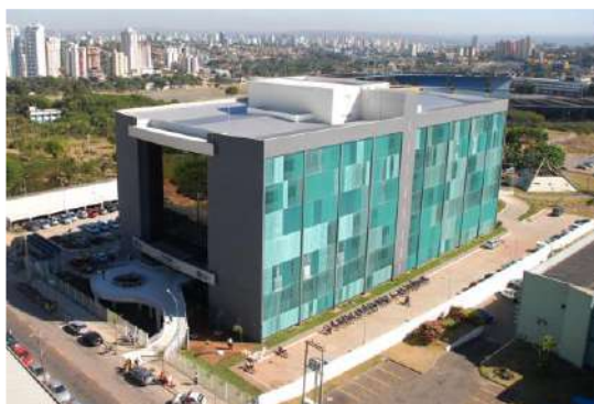
Figura 3 – Fachada Fórum Criminal de Goiânia -
