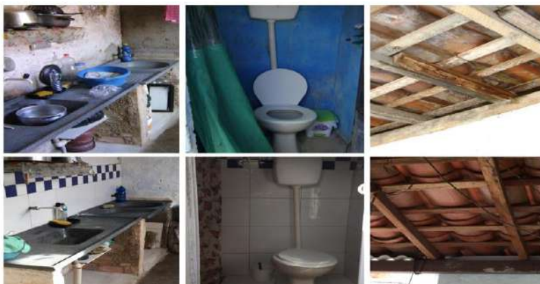
Figura 7 – Melhorias realizadas na casa F -
