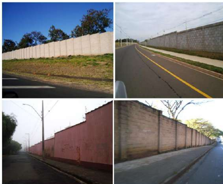
Figura 1 - Falta de Permeabilidade – muros cegos dos CHF's
