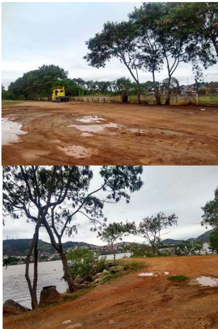
Figura 8 – Vistas da área de intervenção
