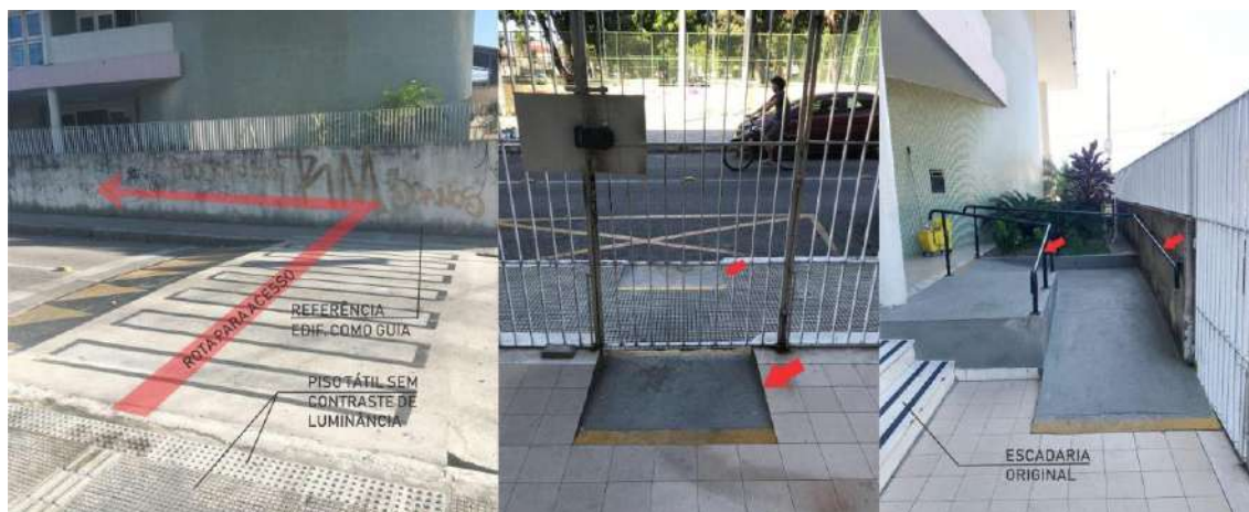
Figuras 4, 5 e 6 – Faixa elevada, rampa para jardim, rampa para pilotis -
