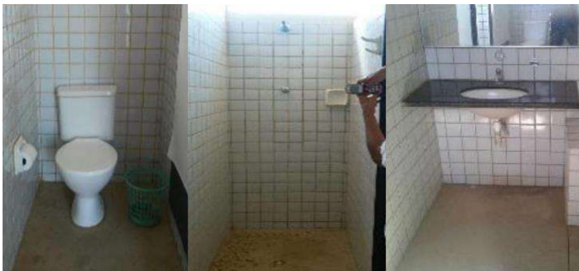
Figura 6 – Boxes com sanitários e chuveiro, respectivamente -
