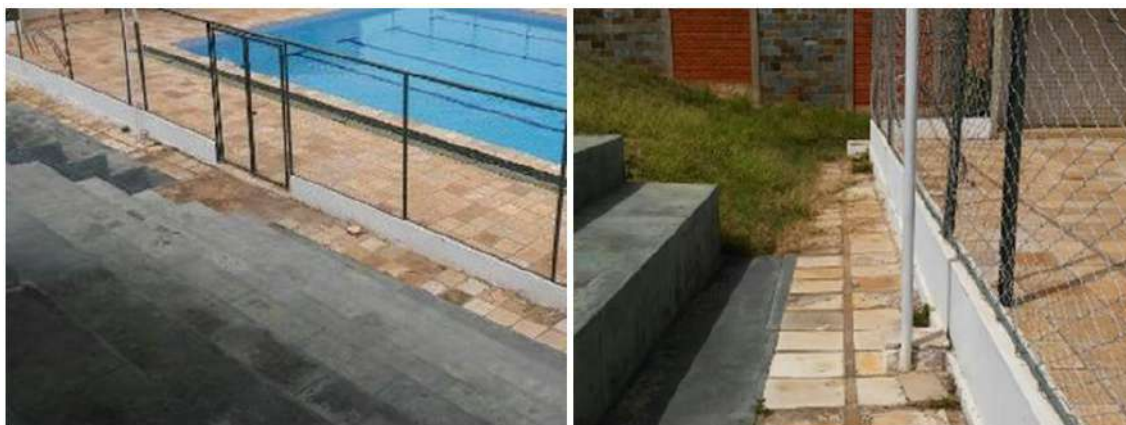
Figura 3 – Arquibancada e circulação de acesso, respectivamente -
