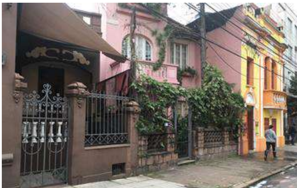
Figura 6 – Percurso 5: Rua José do Patrocínio - Edificações desalinhadas em relação ao passeio
