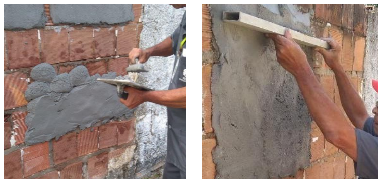
Figura 1 e 2. Argamassa: aplicação manual e sarrafeamento em parede sem chapisco
