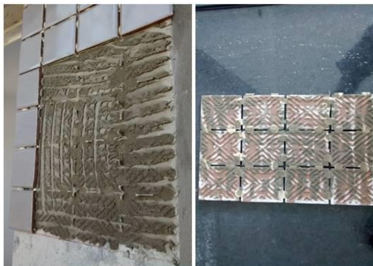
Figura 1 – Exemplo de falhas de preenchimento da argamassa colante no tardez da placa cerâmica
