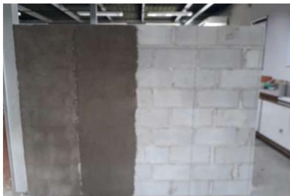
Figura 2 - Preparação da base com bloco cerâmico.
