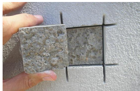
Figura 2 - Corte quadrado efetuado com disco de corte
