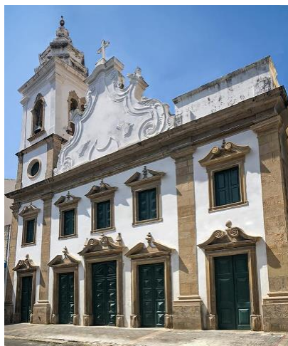
Figura 1 – Fachada da Igreja de Nossa Senhora da Conceição dos Militares
