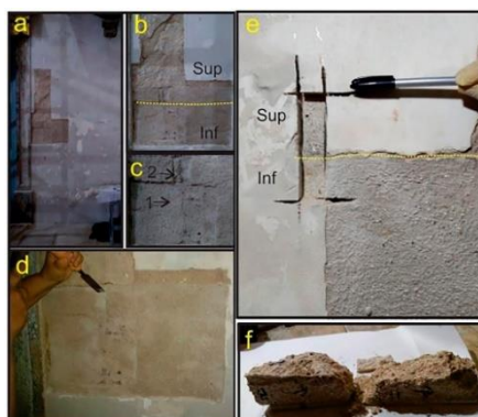
Figura 2 - (a) Vista da parede esquerda da igreja (b) Localização da parte superior e inferior desta parede (c) Localização específica da amostragem 1 e 2
