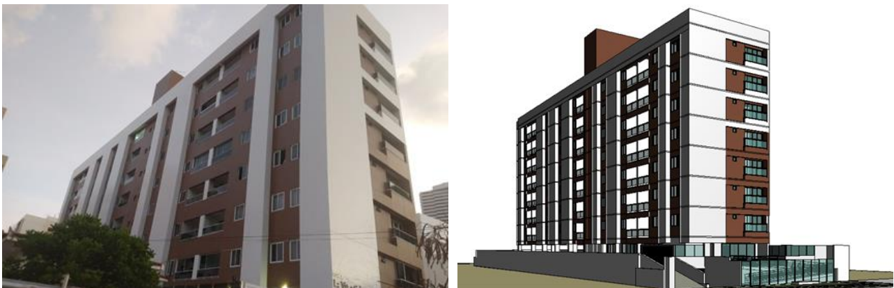
Figura 5: Edifício real construído em João Pessoa, PB, em 2015
