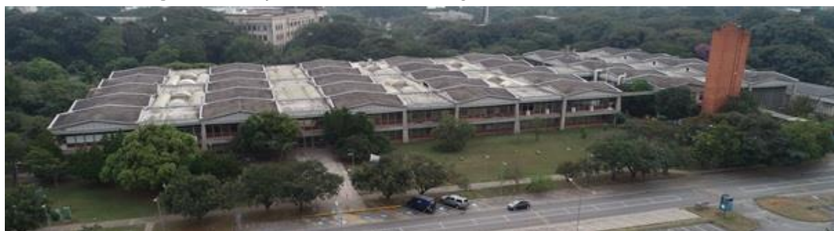
Figura 2 – Edificação em estudo: Edifício de Engenharia Civil e Ambiental – EP/USP
