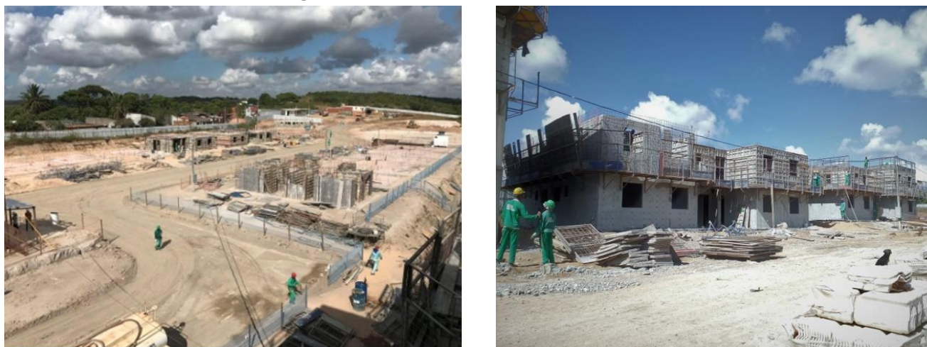
Figura 1: Vista do canteiro e blocos 28 e 29 estudados.
